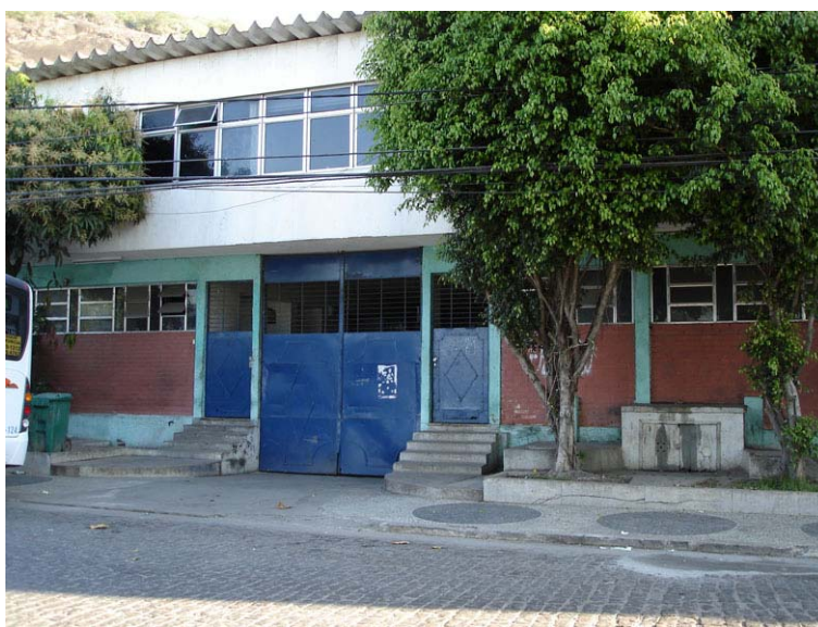
Figura 7 - Prédio da antiga Fábrica Santa Iria, na região do Ponto Final. Foto da autora.
