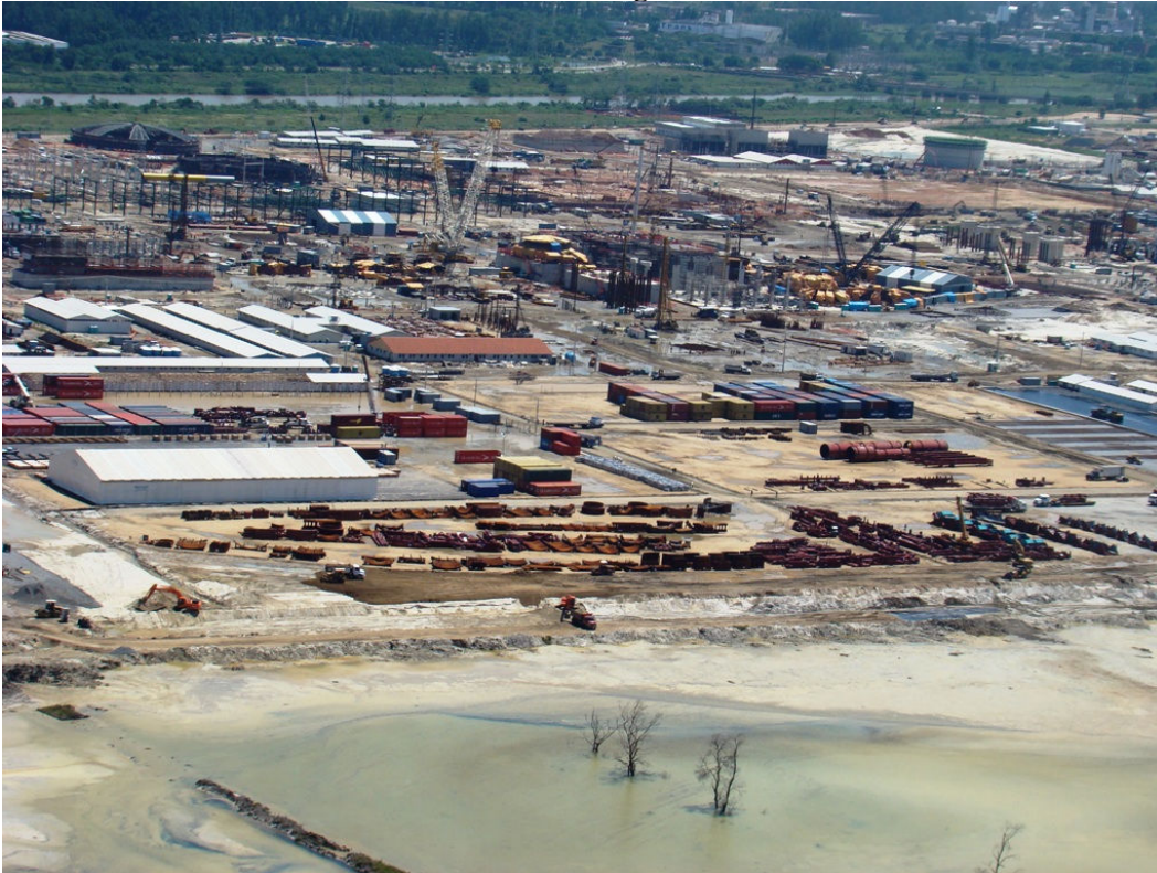
14. Obra no terreno da CSA – observar manguezal morto mais embaixo
