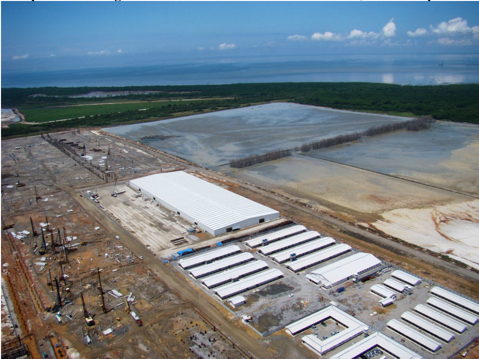
15. Obra no terreno da CSA – observar novamente a bacia de contenção de água, com parte do manguezal morto. Mais bate-estacas na foto, mais a esquerda.
