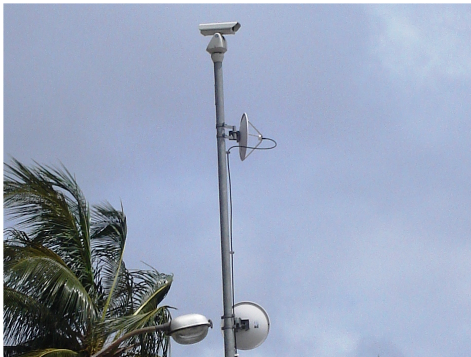
Fig. 10: Câmera de vigilância, conectada à antena de transmissão das imagens via rádio
