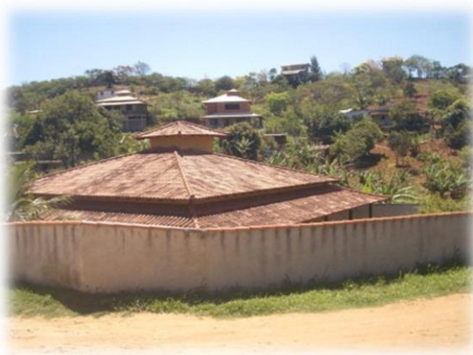
Figura 72: Novas construções no Bairro de José Gonçalves - subindo a Serra das Emerências
