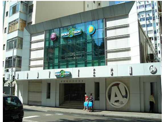
Figura 16 - Demolição do Cine Copacabana – 2012 Para Construção de Academia de Ginástica
