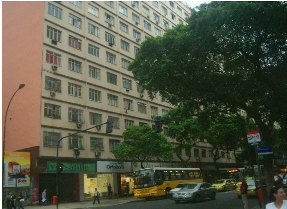
Figura 18 - Edifício Richard – O Mais Populoso Prédio de Copacabana
