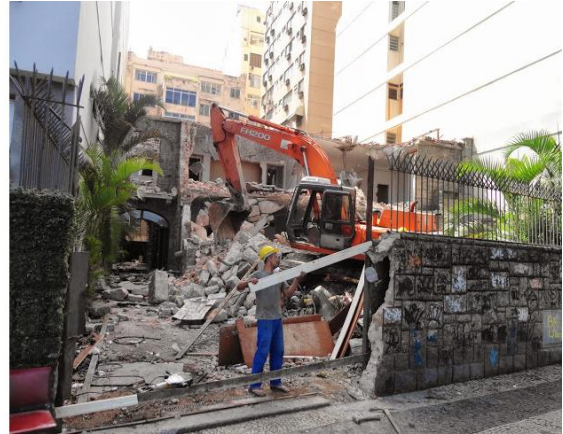
Figura 25 - Casa de Pedra Demolida em Outubro de 2013
