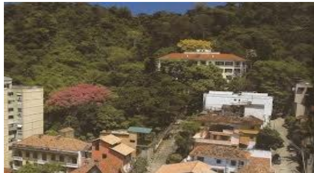
Figura 5 - Vista Parcial do Condomínio Santa Leocádia - Copacabana
