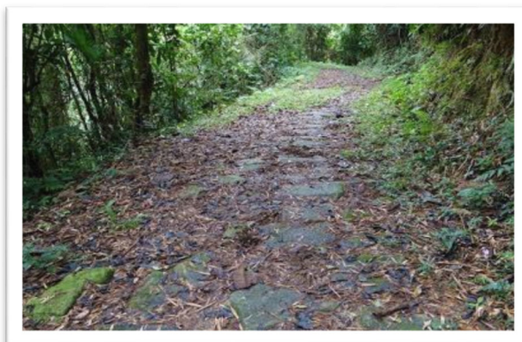
FOTO 20 – Parte da trilha construída em pedras
