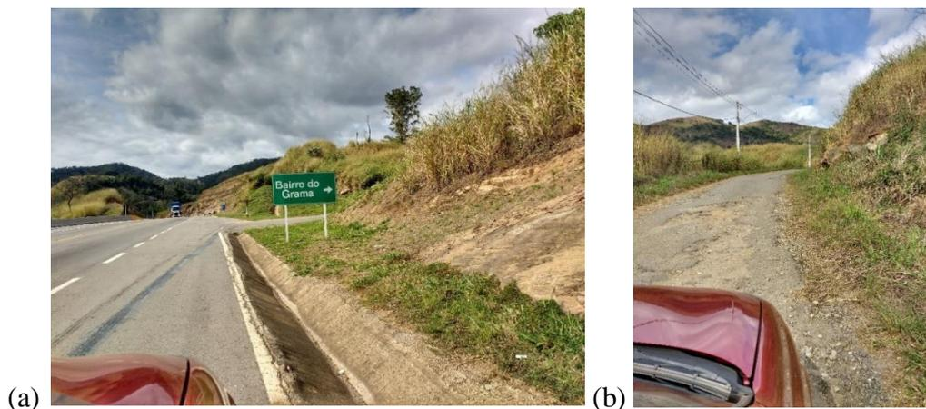
Figura 25. (a) Acesso na BR-393 ao Bairro da Grama; (b) Calçamento deteriorado e inclinação íngreme da estrada de acesso ao bairro.
