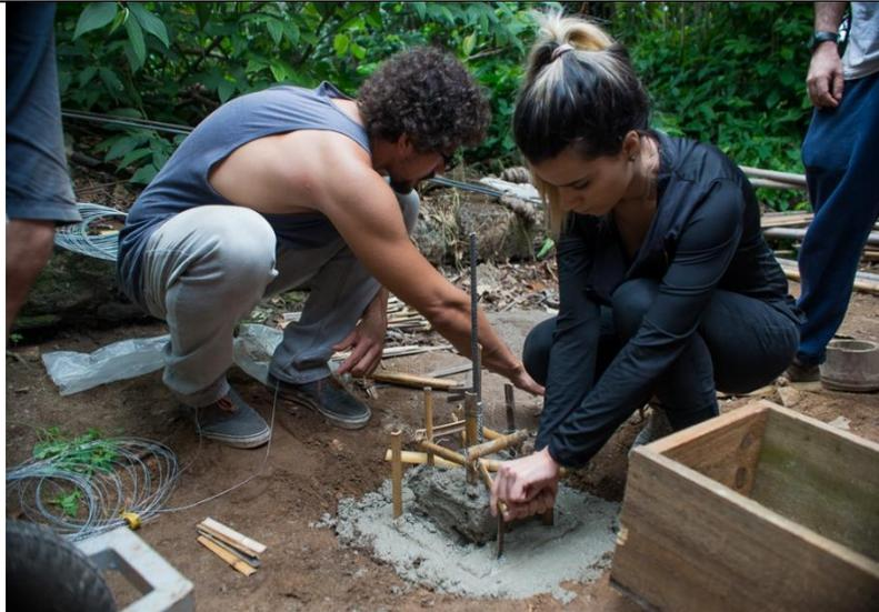
Figura 23: Preparação da fundação da estrutura a ser construída no curso de Bioconstrução
