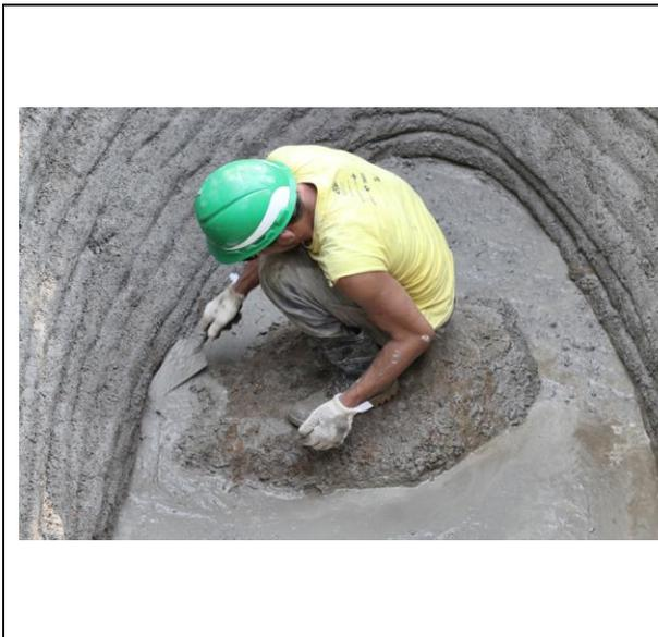
Figura 58: Construção do piso impermeável do tanque de evapotranspiração.
