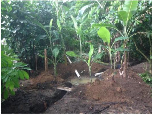
Figura 76: Tubulação conectada a círculo de bananeiras em construção.
