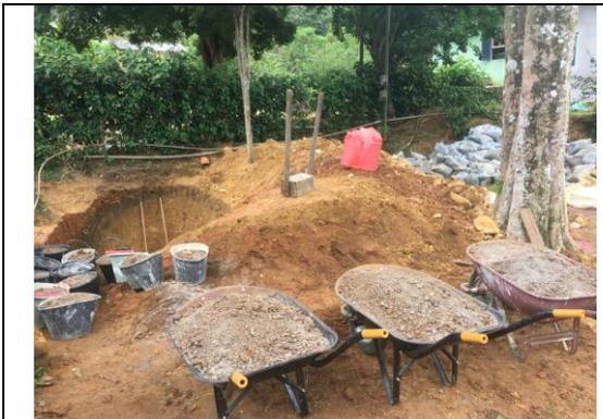
Figura 42: Carrinhos com mistura estabilizada de terra e cimento para preenchimento das linhas de superadobe
