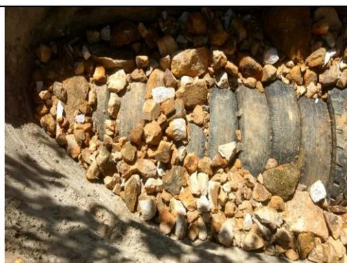
Figura 63: Cobrindo a câmara de biodigestão com entulho.
