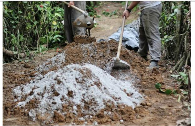
Figura 41: Estabilização da terra escavada com cimento para preenchimento das linhas de superadobe.
