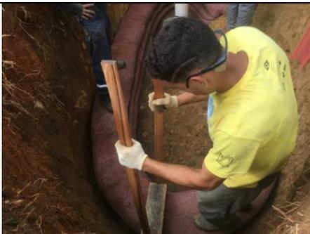
Figura 50: Linha de superadobe sendo pilada.
