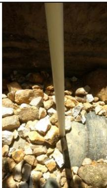
Figura 64: Cano para remoção do gás instalado.
