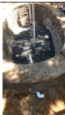
Figura 69: Colocando brita no sistema.
