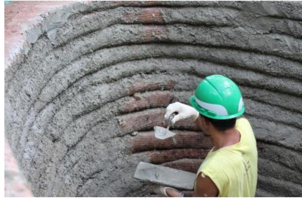
Figura 53: Aplicação de chapisco sobre as paredes de superadobe.
