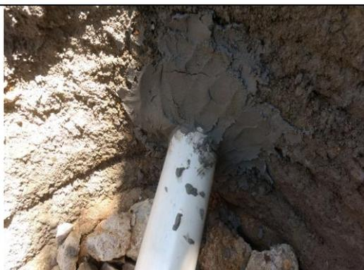
Figura 68: Chumbando tubulação de saída por dentro.
