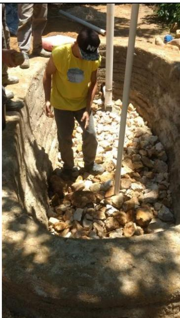
Figura 66: Terminando de colocar entulho na câmara de digestão.
