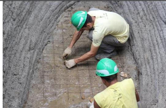
Figura 57: Construção do piso impermeável do tanque de evapotranspiração.
