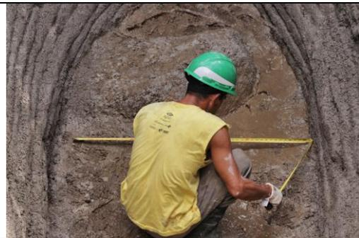
Figura 55: Construção do piso impermeável do tanque de evapotranspiração.
