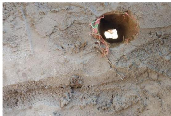
Figura 61: Furo para instalação de tubulação de entrada
