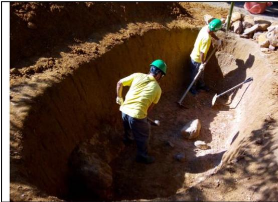
Figura 40: Escavação para tanque de evapotranspiração.
