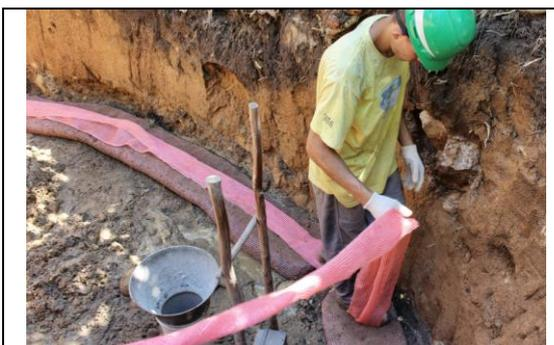
Figura 44: Disposição do saco para preenchimento das linhas de superadobe.
