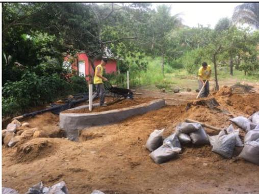
Figura 72: Colocando terra fértil no sistema.
