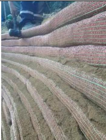
Figura 52: Detalhe do assentamento das linhas de superadobe.
