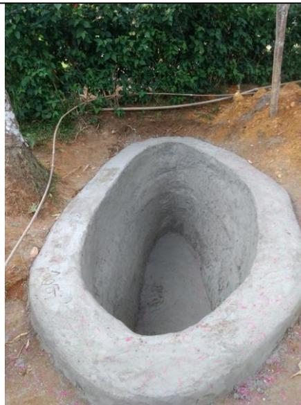
Figura 59: Tanque de evapotranspiração chapiscado e emboçado, pronto para ser preenchido.
