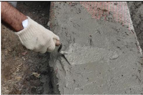
Figura 54: Aplicação de massa impermeabilizante sobre as paredes de superadobe.
