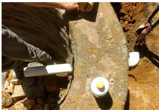
Figura 67: Instalando tubulação de ladrão no sistema.
