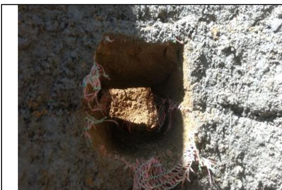
Figura 62: Furo para instalação de tubulação de entrada do esgoto.
