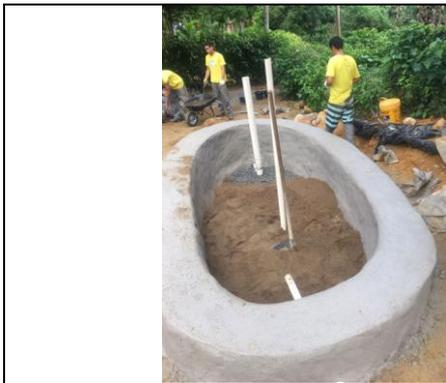
Figura 70: Colocando areia no sistema.
