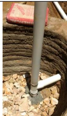
Figura 65: Instalação da tubulação de entrada do esgoto.
