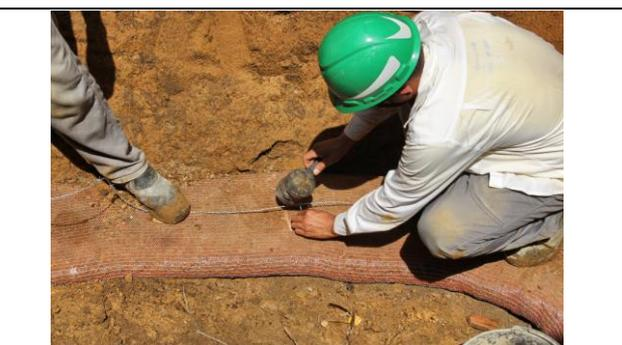
Figura 45: Linha de arame farpado entre as linhas de superadobe para melhor fixação.
