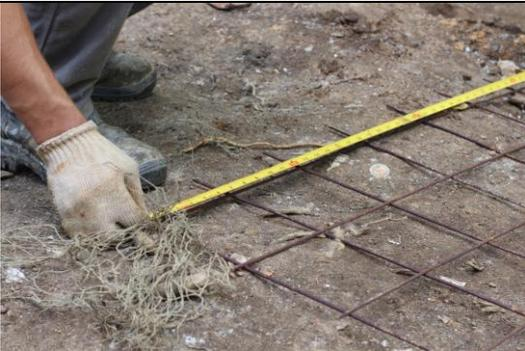
Figura 56: Construção do piso impermeável do tanque de evapotranspiração.
