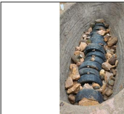
Figura 60: Assentamento de Pneus para formar a Câmara de Digestão com entulho para formação do leito de filtragem.
