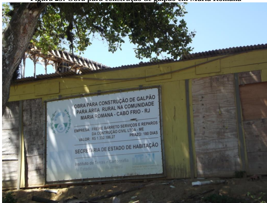
Figura 25: Obra para construção de galpão em Maria Romana
