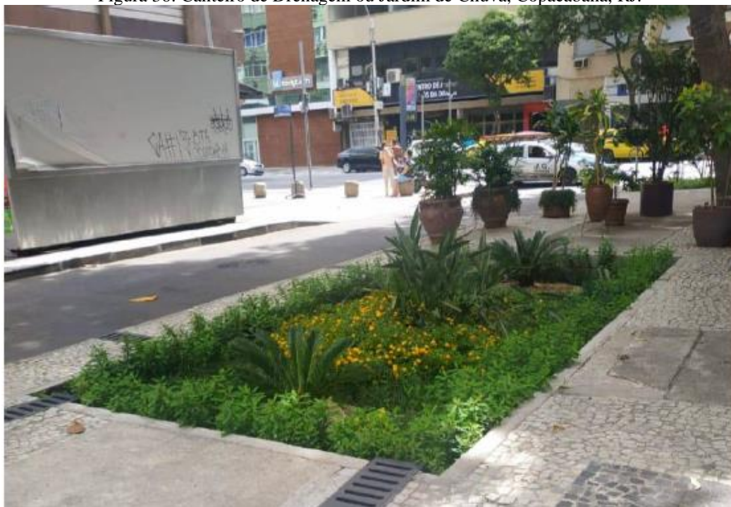
Figura 36: Canteiro de Drenagem ou Jardim de Chuva, Copacabana, RJ.
