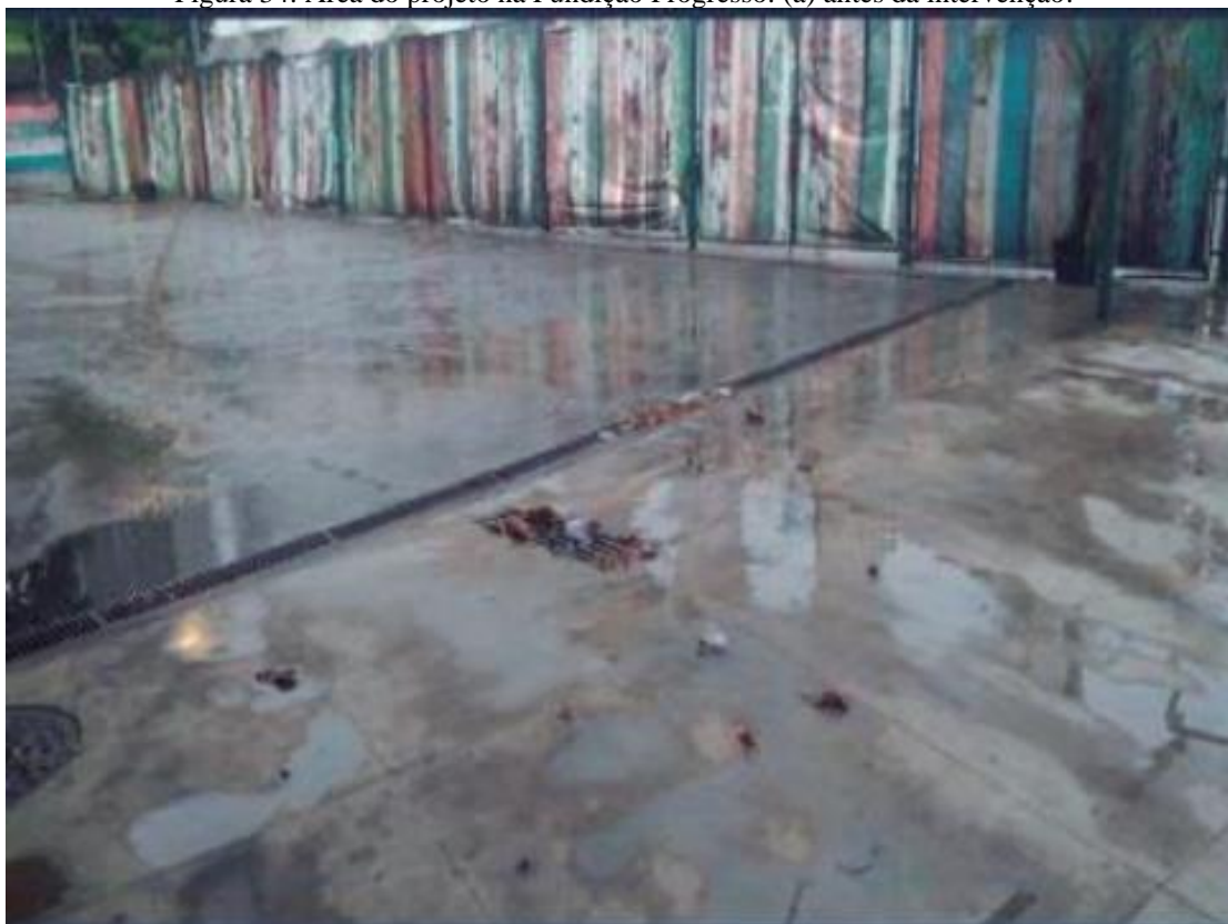
Figura 34: Área do projeto na Fundação Progresso: (a) antes da intervenção.
