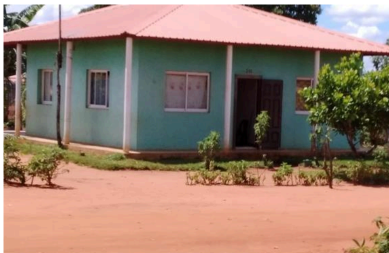
Foto 10 - Modelo de casa distribuída aos reassentados em Nwamuza no novo bairro
