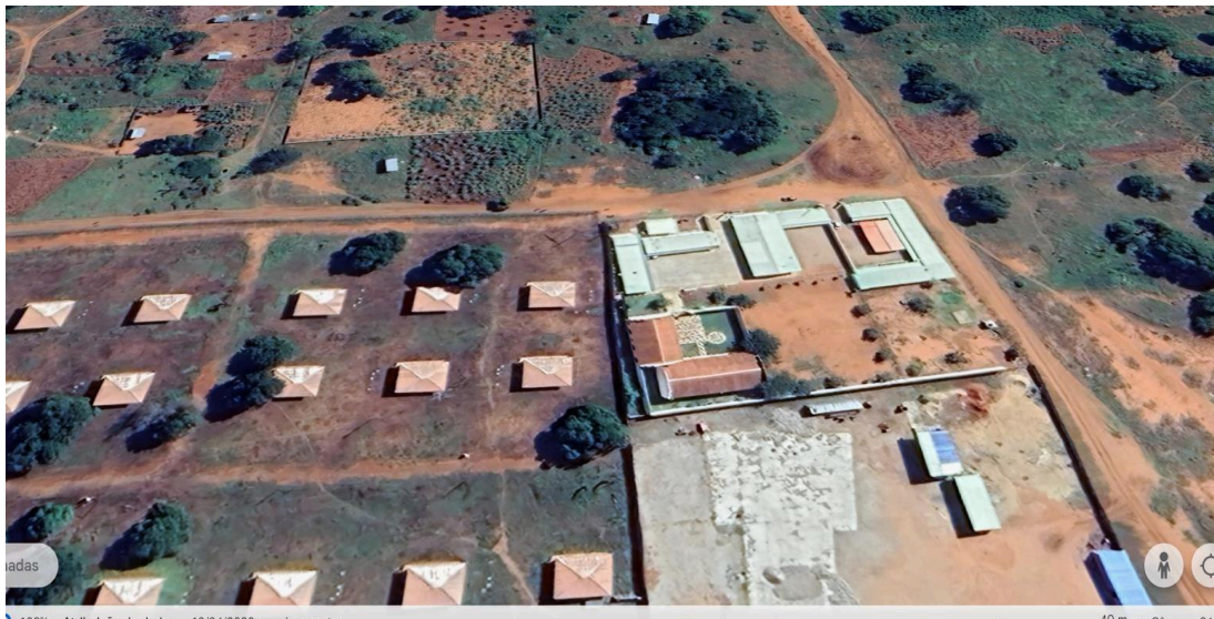
Foto 6 - O estaleiro que se tornou em escola e posto de saúde.
