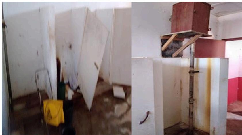
Foto 14 - Casa de banho da unidade sanitária construída pela Dingsheng
