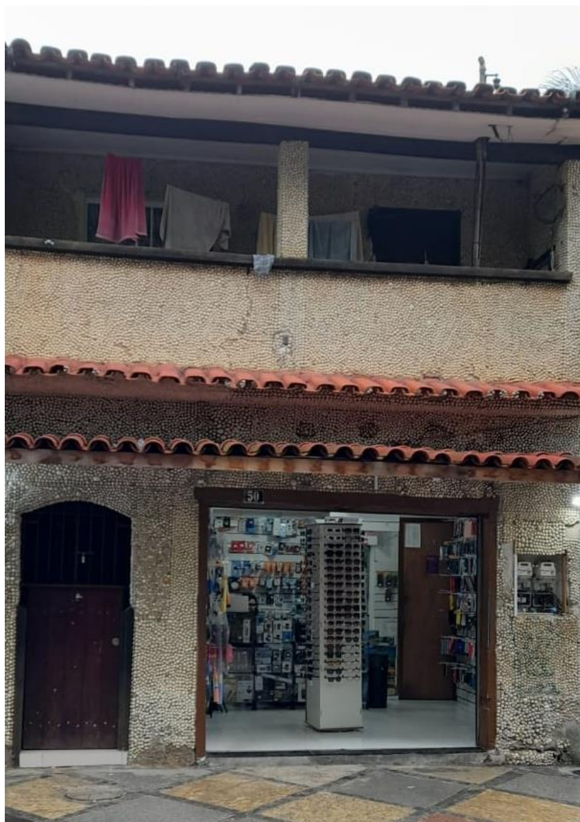
Figura 33: Registro fotográfico de uma casa construída pela comunidade à base de conchas das praias locais.
