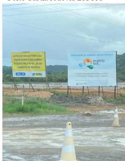
Figura 24 – Placas anunciando o Porto Sul na rodovia BA 001
