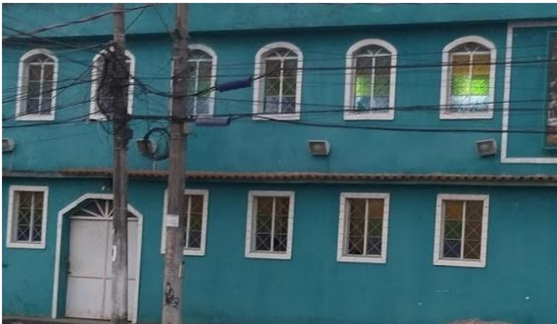
Figura 10. A igreja evangélica sempre intacta sem depredações. Fonte: foto do autor.
