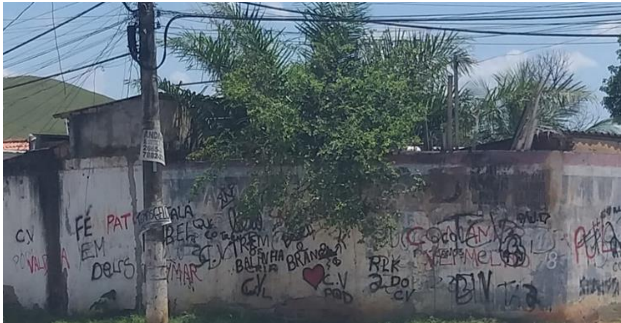
Figura 11. Fachada do terreiro toda pichada pelos traficantes. Fonte: foto do autor
