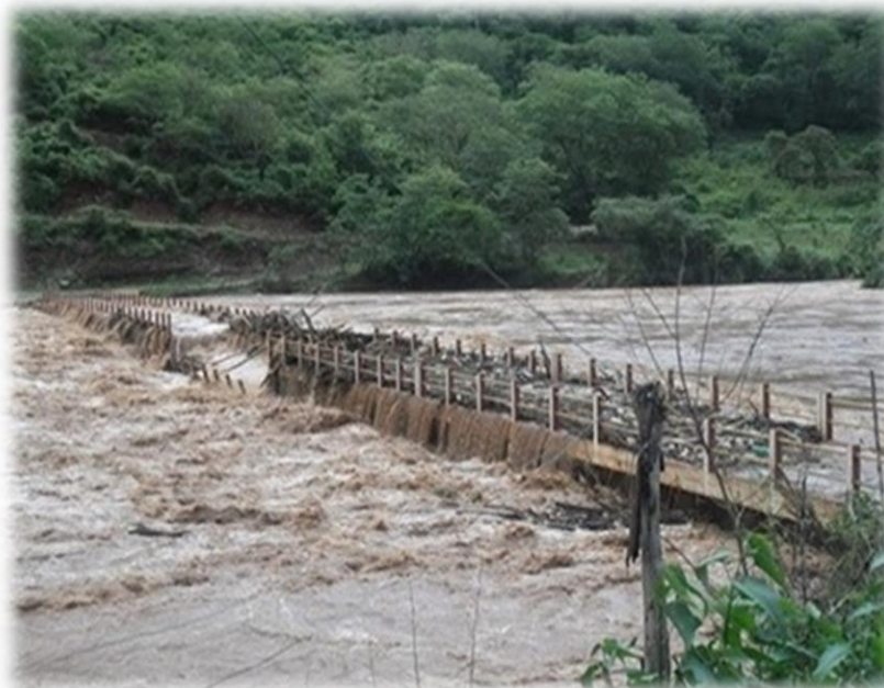
Figura 21 - Fotografia da Ponte Nova de Santa Rita sendo atingida pelo “Dilúvio” de 2013.
