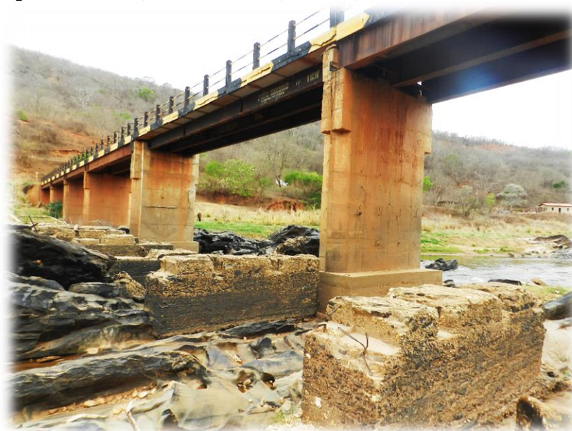
Figura 22 - Fotografia mostrando a Ponte Nova que liga o Distrito de Santa Rita do Araçuaí e a Sede de Chapada do Norte, demonstrando, ao lado, a estrutura da base da antiga ponte.
