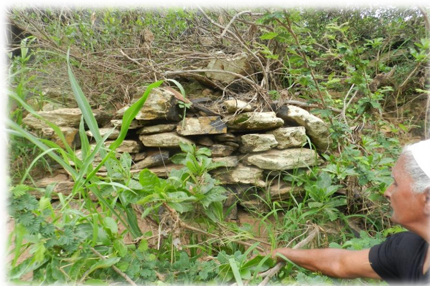
Figura 12 - Fotografia de Dona Alzira apontando para trecho da estrutura da calçada de pedra dos escravos
